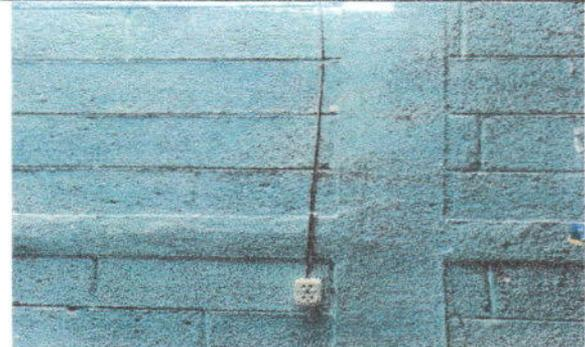
Foto 2: Sustrucción de ducto electrico y cambio de accesorios.
